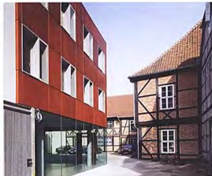
Der Neubau des Domhofs (1998) im Altstadt-kern von Schwerin orientiert sich am Gebäudevolumen und der Farbgebung für die hölzernen Fassadenpaneele an den benachbarten Fachwerkhäusern
