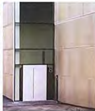
Dreifeldsporthalle in Schwerin, 2007
